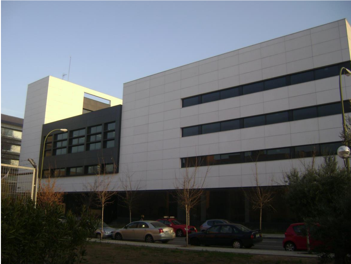
Fachada General del Inmueble
