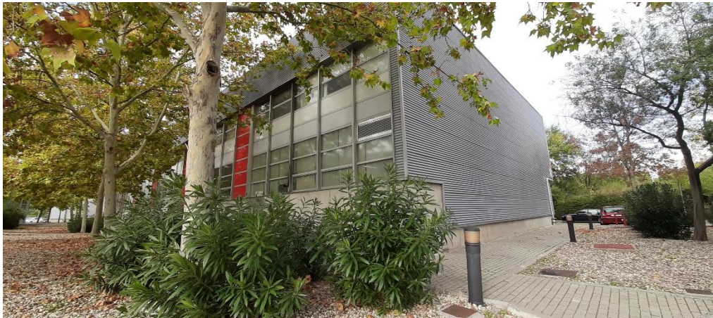
Imagen 2 Imagen exterior del edificio A. Nave industrial
